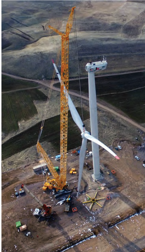
Izgradnja vetroparka kompanije MAPNA u Akandu, u pokrajini Istočni Azerbejdžan. Domaćinstva će električnom energijom snabdevati dvadeset vetroturbina, svaka sa kapacitetom od 2,5 MVs.
